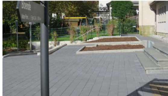
Nachher: Die Erweiterung des Kindergarten-Grundstücks, die rollstuhlgerechten Wege mit Rampe zum Hauptportal inmitten der Pflanzbeete sind bestens gelungen. Pflanzen, Geländer, Bänke u. Lampen folgen.
