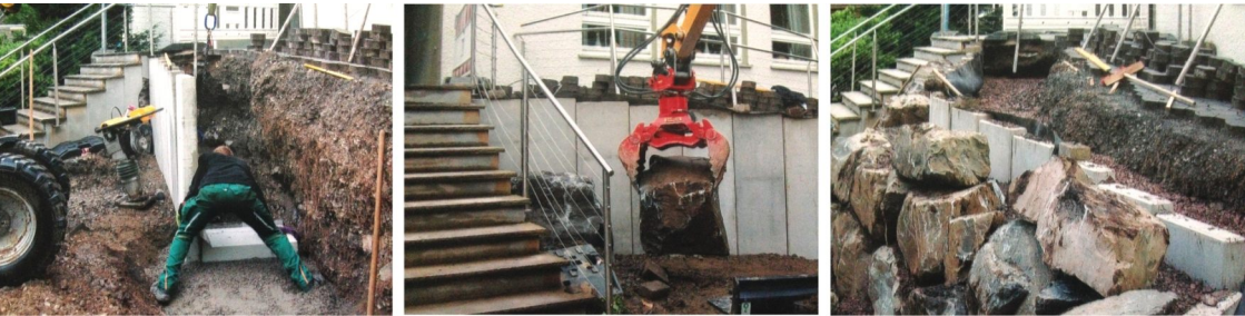
Von li. n. re.: Der Felssteinaufbau unterhalb des rollstuhlgerechten Aufgangs zum Gemeindehaus wurde entfernt und sicher stützende L-Betonsteine eingebaut. Die schweren Felsen sitzen wieder davor und kaschieren den Beton. Fotos Peter Hischer
