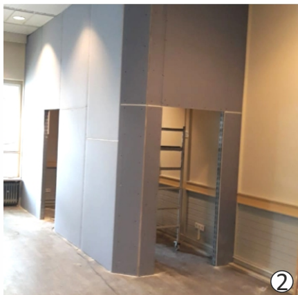
1 - Stahlgerüste als Wandbasis 2 - Fertig montierte Rigipsplatten 3 - Glatt verspachtelte Rigipsplatten 4 - Eingebaute Türen, obere Wandbereiche tapeziert 5 - Alle Leisten und Brettchen wurden angebracht, Stil und Farben passend zur alten Wand ganz rechts.
