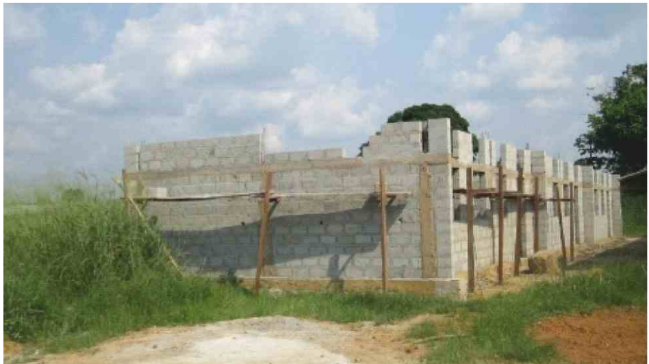
Rohbau des neuen Schulgebäudes (noch ohne Dach)
